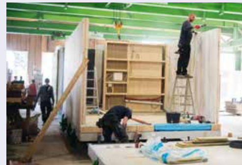
Arbeiten in der "Feldfabrik" (Foto: Andreas Mauritz)
