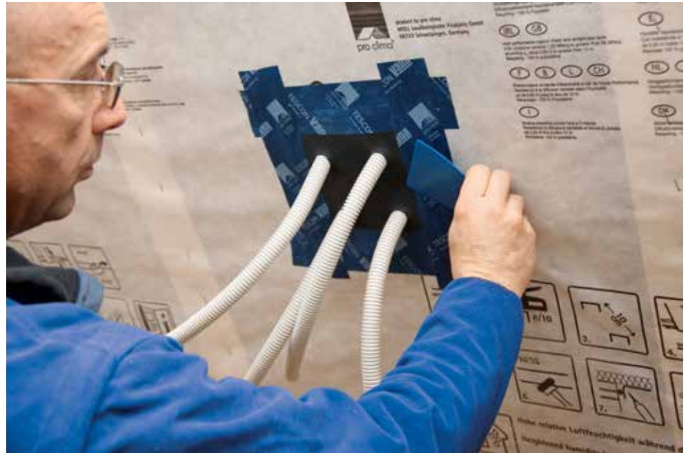
Abbildung 15: Abdichten von Durchführungen, Quelle: pro clima
